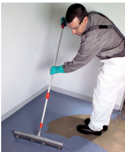
Abb. 5: Auftrag von Epoxidharzen mit den notwendigen Schutzmaßnahmen (Quelle: MC-Bauchemie)
