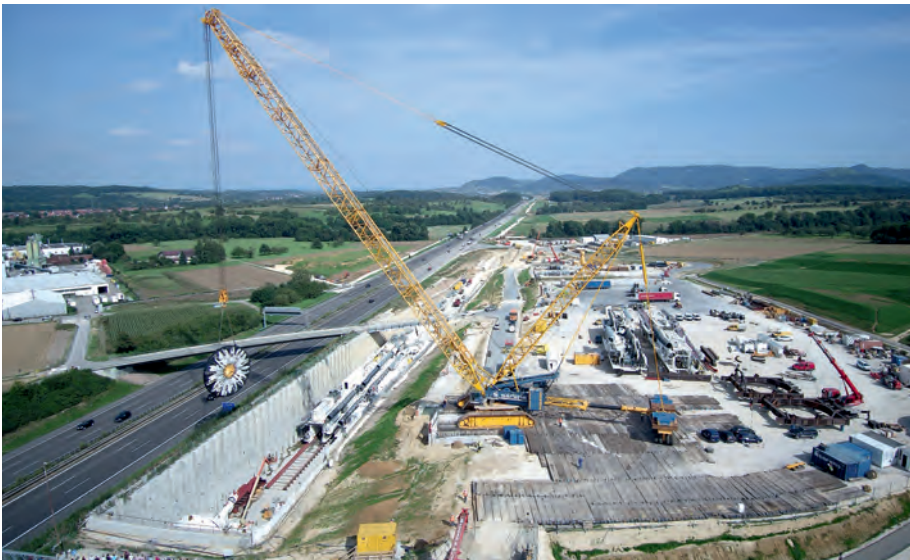
Abb. 4: Das Schneidrad der TVM wurde mit einem Schwerlasttraupenkran montiert
