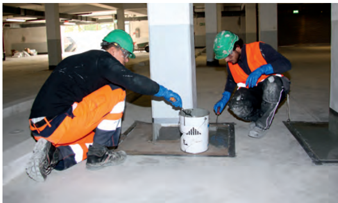
Abb. 1. Verarbeitung von Epoxidharzen (Quelle: Kersting)
