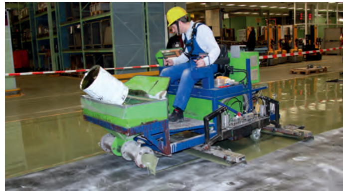
Abb. 3: Auftrag von Epoxidharzen mit einem Fertiger (Quelle: Kersting)
