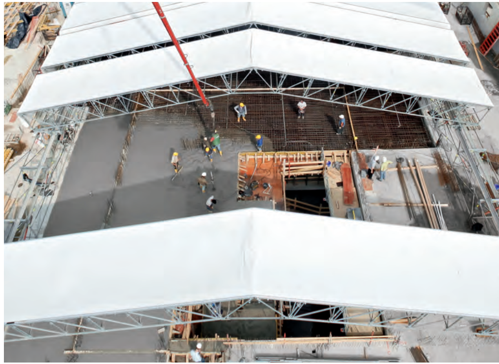
Abb. 4: Wetterschutzdach Peri UP LGS mit Kederplane fahrbar auf Schienensystem (Quelle: Peri GmbH)
